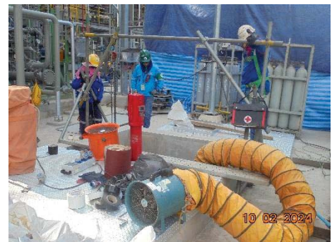
ภาพที่ 2.2-33 เครื่องระบายอากาศ บริเวณพื้นที่อับอากาศ
