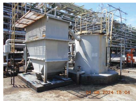
ภาพที่ 2.2-16 ระบบบำบัดน้ำเสียแบบ CPI ของโรงผลิตน้ำมันหล่อลื่นพื้นฐาน (LBOP)
