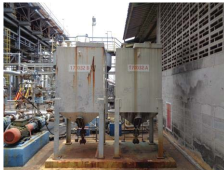
ภาพที่ 2.2-19 Slop Oil Tank เพื่อรวมครบน้ำมัน จากบ่อบำบัดน้ำเสีย CPI/IAF
