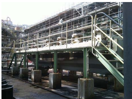
ภาพที่ 2.2-8 บ่อพักน้ำเสีย IAF หน่วย ADU
