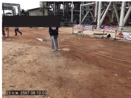
ภาพที่ 2.2-1 การฉีดพรมน้ำบริเวณพื้นที่ก่อสร้าง
