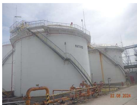
ภาพที่ 2.2-50 การติดตั้ง Dome Roof
