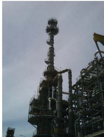
ภาพที่ 2.2-3 ปล่องระบายของหน่วยปรับปรุงคุณภาพน้ำมันดีเซล (DHT) (DHT Heater)
