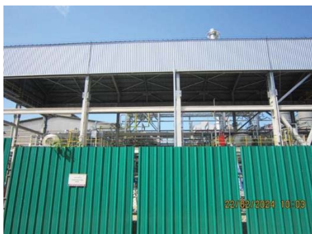
ภาพที่ 2.2-12 รั้วชั่วคราวที่ทำจากแผ่นเหล็กชุบสังกะสี (Metal Sheet)
